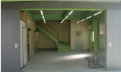
図-5 屋内作業場
