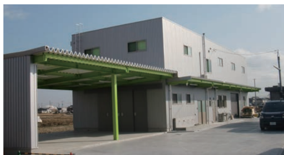
図-1 研究センターの外観
