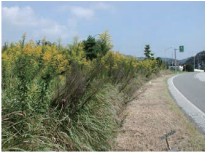
図-3 大型強雑草の過繁茂等により荒廃したインターチェンジランプの芝生地
