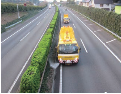
図-12 中央分離帯における散水車散布の様子
