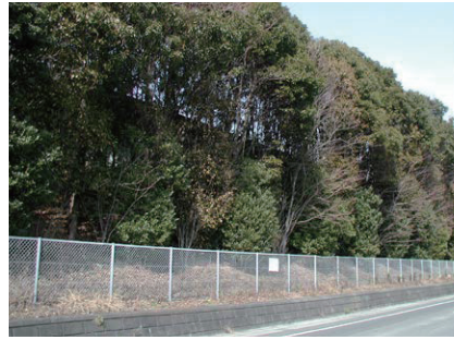
図-4 盛土のり面樹林化植栽
