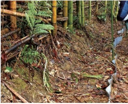
図-14 地下茎の伸長を阻止する遮蔽板
