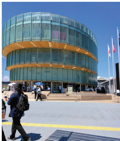
図-1 チェコ・パヴィリオン PLT工法とは辺材と心材を組み合わせる機械的強度を強化した材で全てチェコ産のトウヒを用いて作成された。
