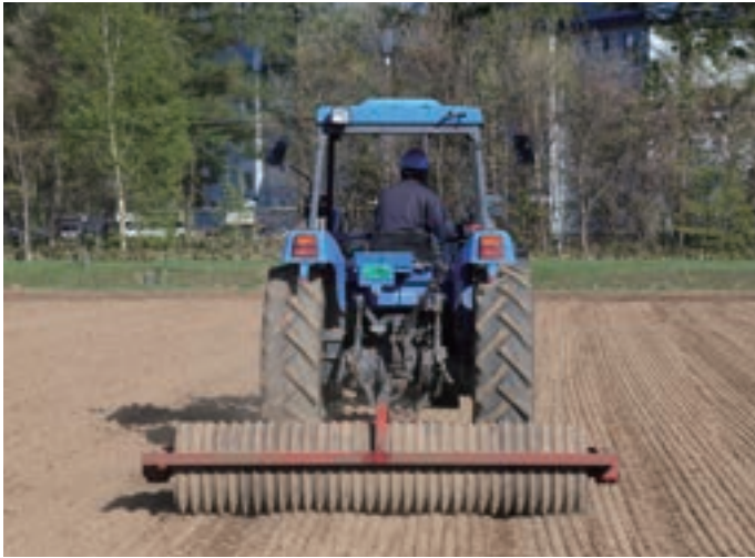
図-3 ケンブリッジローラによる鎮圧
