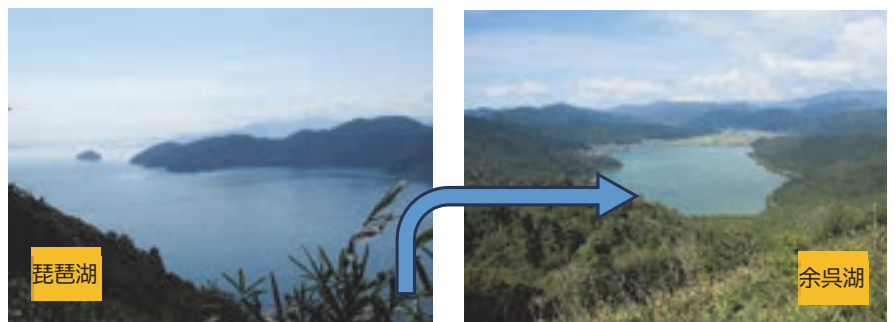
図-2 余呉湖補給揚水場(琵琶湖側)から余呉湖へポンプアップ
