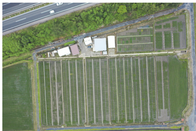
図-1 上空から見た古川研究センター全景
