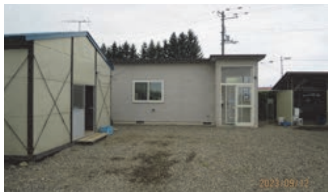
図-1 事務室（中央）と調査室（左）
