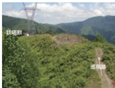
山地の送電線と鉄塔敷
