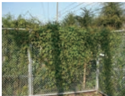
図-5 フェンス（ラス金網）に絡まるツル植物
