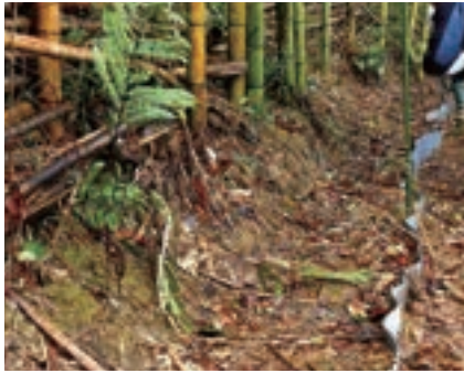
図-14 地下茎の伸長を阻止する遮蔽板
