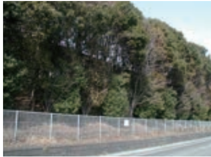
図-4 盛土のり面樹林化植栽
