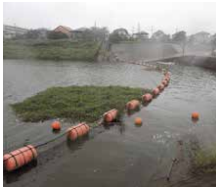
図-9 排水機場に漂着する浮島状のナガエツルノゲイトウ群落
