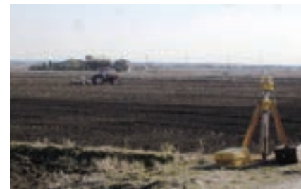
写真-1 レーザーレベラーを使った大区画圃場の均平作業 (一般社団法人 大日本農会提供)
