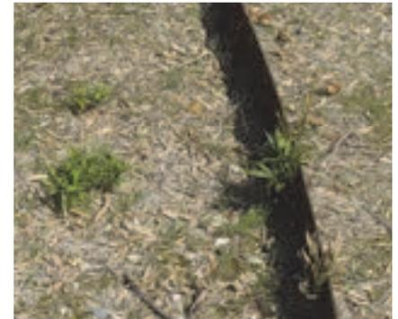
図-11 地下茎の伸長を阻止する遮蔽板
