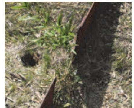
図-12 遮蔽板の隙間から地下茎が伸長し，外側（左側）に発生した小竹
