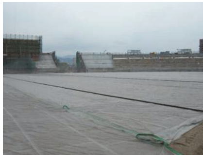
写真-4 乾燥防止のシート設置
