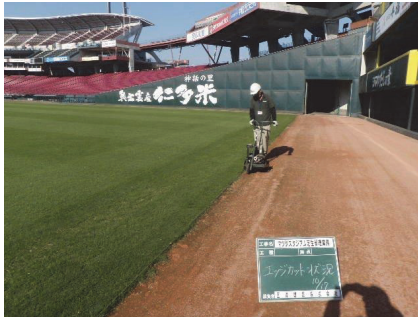
写真-31 エッジカット
