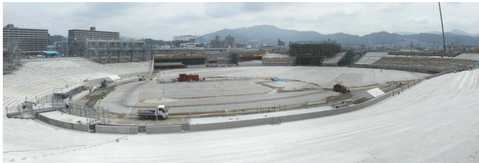
写真-5 7月11日シート設置中
