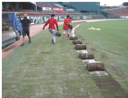
写真-12 外野外周部の張替
