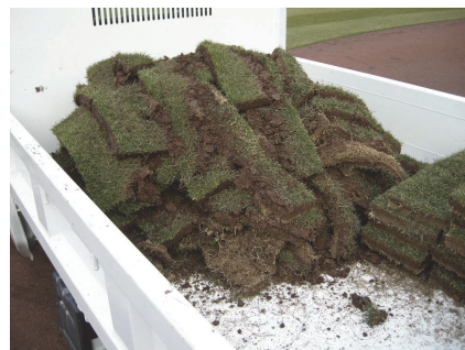
写真-30 土混じりの芝の撤去処分
