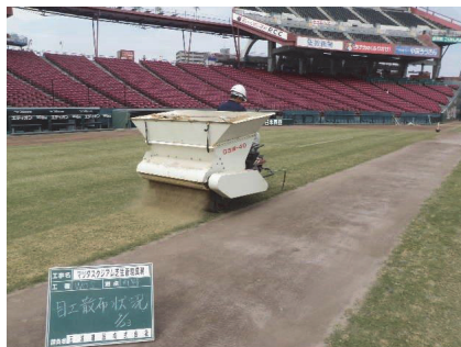
写真-26 目土散布
