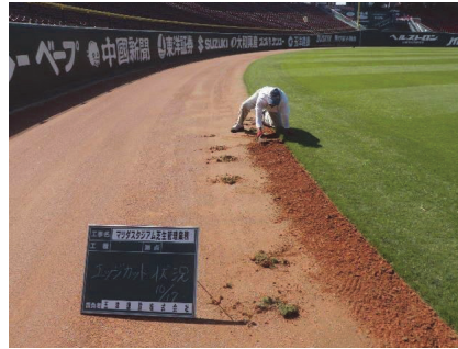
写真-32 除根処理
