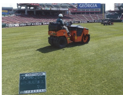
写真-22 ローラー転圧
