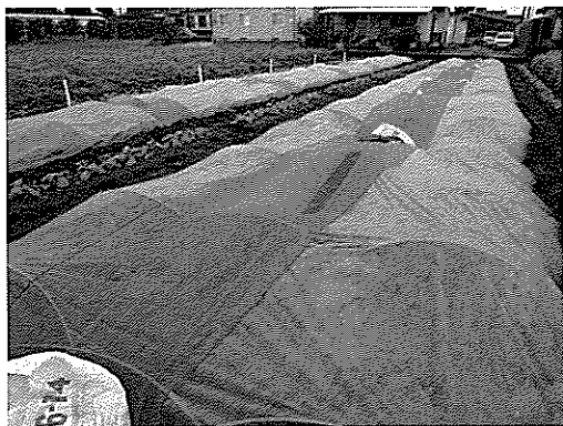
写真-7 不織布による台風対策
