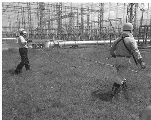
写真-7 変電所構内での薬剤散布
