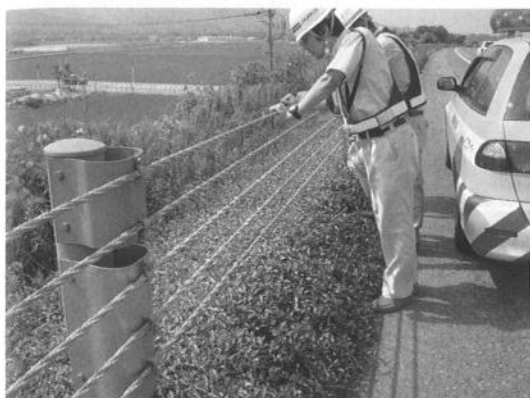
写真-7 テイカが被覆した盛土路肩部
