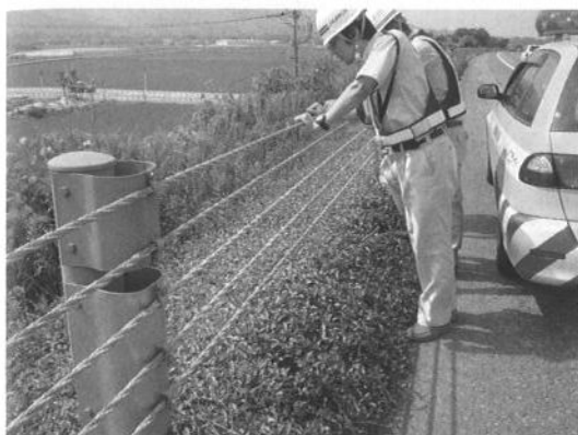
写真-7 テイカが被覆した盛土路肩部
