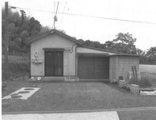
写真-1 試験地事務所全景
