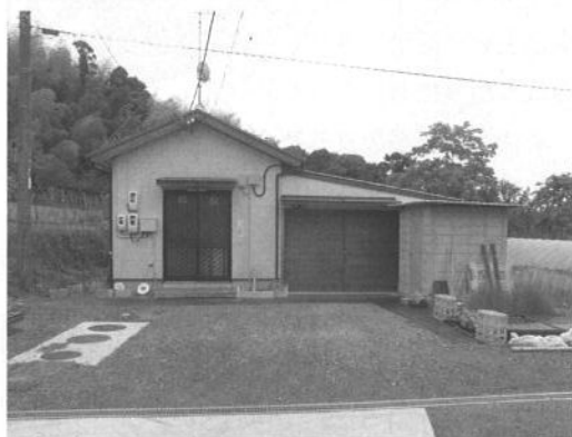
写真－1 試験地事務所全景
