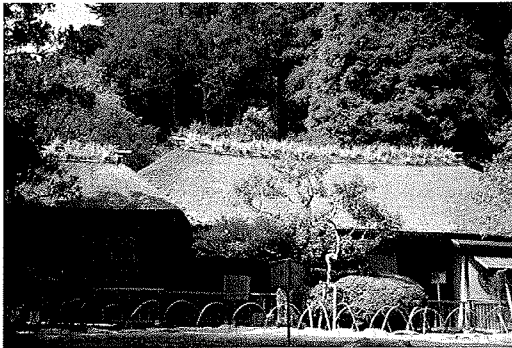
写真－3 芝棟は用・強・美の結晶 水戸光國公の隠居所の芝棟
