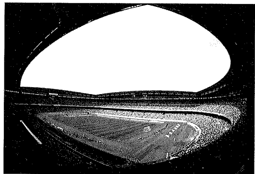
写真－2 2002年サッカーワールドカップの時の横浜国際競技場の芝生。世界一と称された芝生のピッチは排水性能抜群の植栽基盤の賜物
