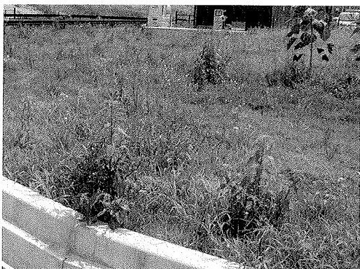
図－9 試験区1 雑草繁茂状況 (H22年8月)
