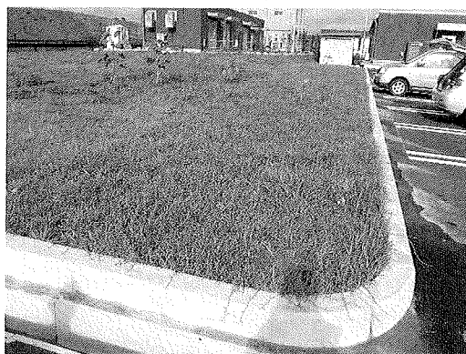
図－9 試験区1～4の状況（H22年6月）
