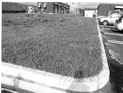
図－9 試験区1～4の状況（H22年6月）
