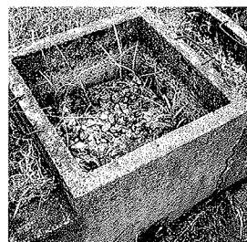
コンクリートポット
