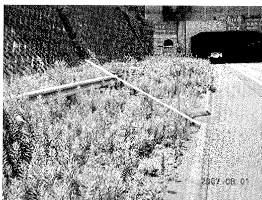
写真-4 路側帯 2007年8月1日（散布7ヵ月後）の状況 （手前側がグリーンフィールド処理区）
