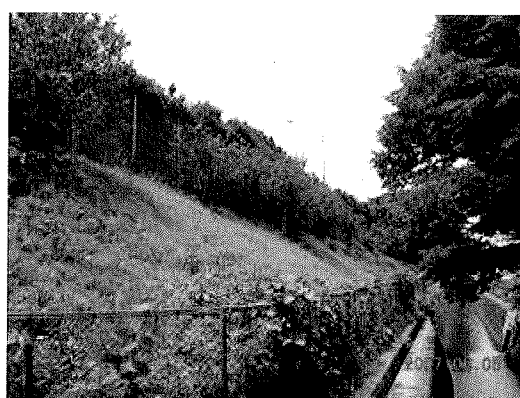
写真-5 側道法面 2007年6月5日（散布4ヵ月後）の状況
