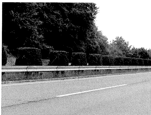
写真-2 中央分離帯 2007年6月21日（散布7ヵ月後）の状況
