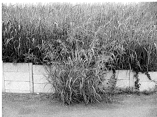
写真-29 堤防一面に密生するセイバンモロコシ 注) 右下は掘り出した地下茎
