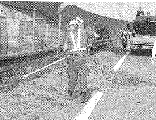
写真－2 中央分離帯の草刈作業
