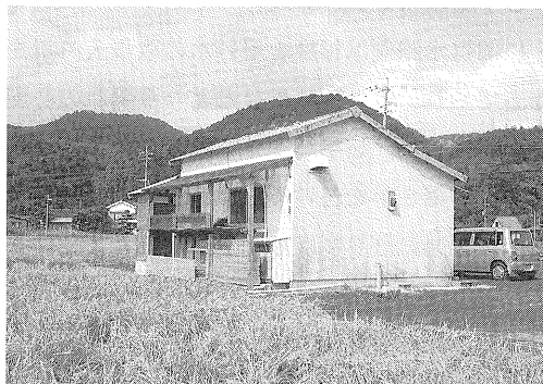
写真-1 事務所兼作業舎 (約40㎡)
