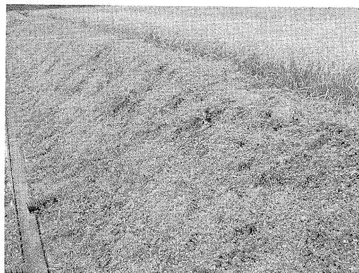
写真-3 張り付け後の状況
