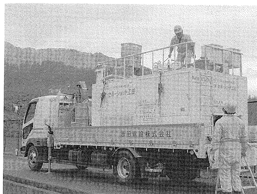
写真-2 トラックに搭載した吹き付け機械
