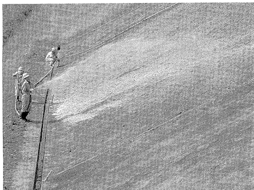
写真-4 法面への吹き付け植栽
