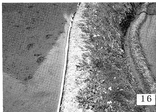
写真-16 あぜ塗りされた前あぜにあぜシートが張られた畦畔（新潟県塩沢町）
