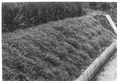
写真-6 現地試験 イワダレソウ植付け後, 約2ヵ月で法面はほぼ覆い尽くされた(平成9年8月14日)
