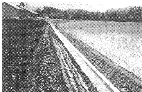
写真-4 現地試験 植付け直後の状況 畦畔上はアジュガ, 法面手前はヒメナデシコ・ナツキソウ, 法面奥はイワダレソウ植付け予定地(平成9年)
