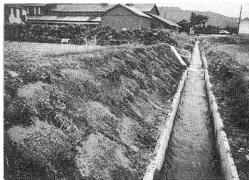
写真-5 現地試験 イワダレソウ植付け直後の状況(平成9年5月29日)
