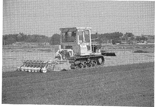
写真-1 ドリルシードによる播種作業
