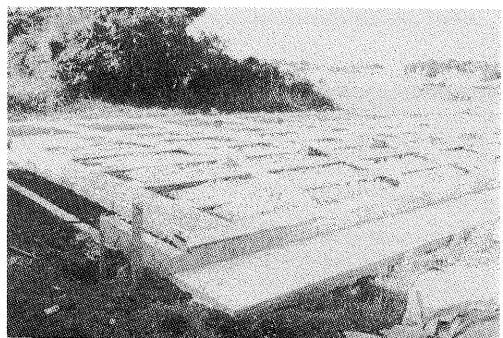
写真-12 温室の骨組みの組立
