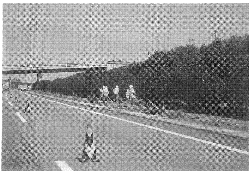
写真5. 高速道路中央分離帯の草刈作業
