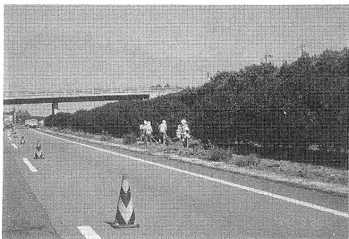
写真5. 高速道路中央分離帯の草刈作業
