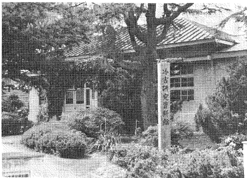
藤坂支場の旧庁舎、現在は冷害研究資料館となっている。
