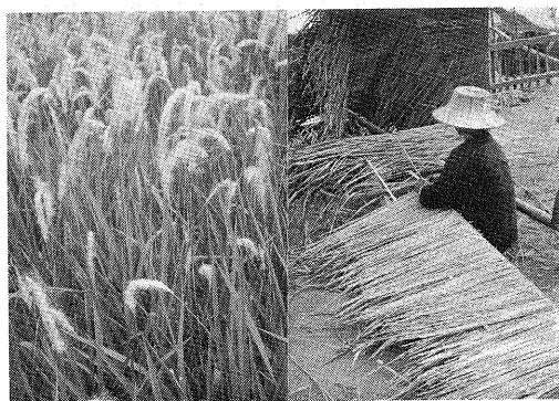
図3. チガヤが屋根ふきの材料として利用される
