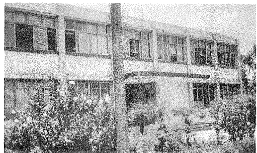
写真9. 新竹改良場新館
