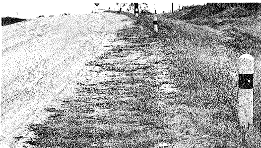
第8図 道肩から路面に侵入するバミューダグラス
