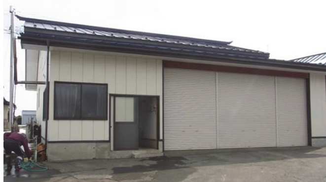
図-2 事務所・作業場
