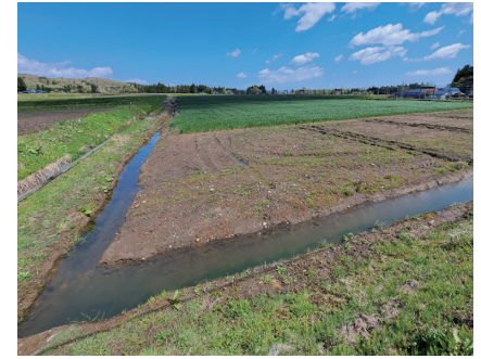
図-2 転換畑の周囲に施工された額縁明渠
