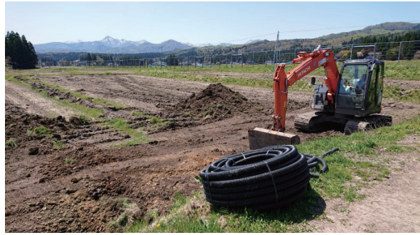
図-5 転作水田の合筆と本暗渠埋設作業
