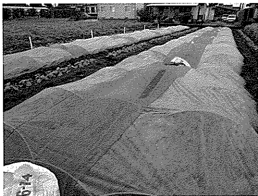
写真-7 不織布による台風対策
