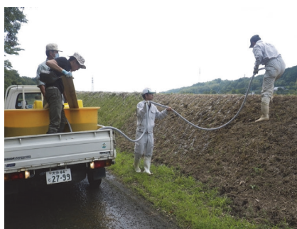
図-3 センチピードグラスの播種作業(2014年)
