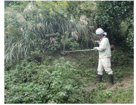
図-7 傾斜地での草刈り作業
