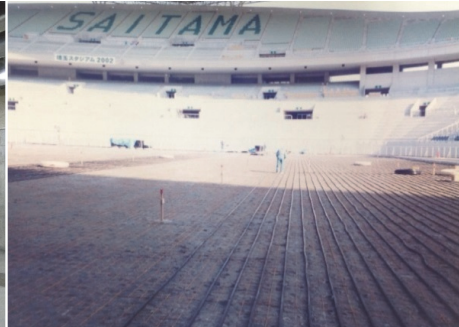
写真-7 冷温水発生装置 (左) と地温パイプ敷設状況 (右)
