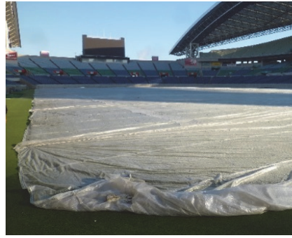
写真-14 シート掛け状況 10m×40m×24枚
