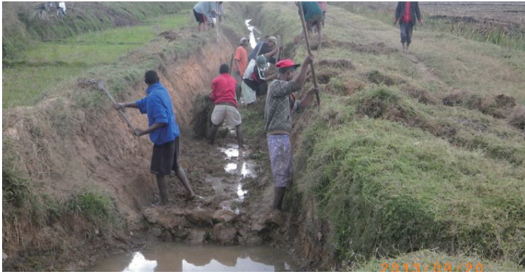
図-7 PC23 地区における二次水路の浚渫作業
