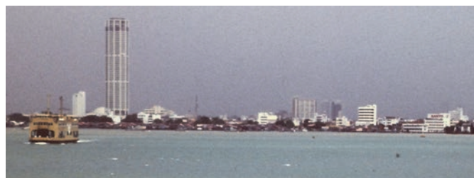
図-2 フェリーポートから眺めるジョージタウン 左端の船は運航中の他のフェリーポートで、その先には60階建てのコムタビルが見える
