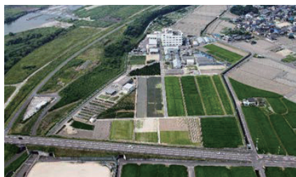
図-1 農業化学研究所（滋賀県野洲市）
